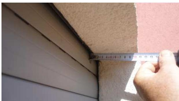
La "veletta", cioè la sezione di parete davanti al cassonetto ha una sezione molto inferiore rispetto a quella della muratura e quindi ha una capacità di isolamento molto bassa. Nella foto la sezione è di 10 cm contro i 40 cm della parete
