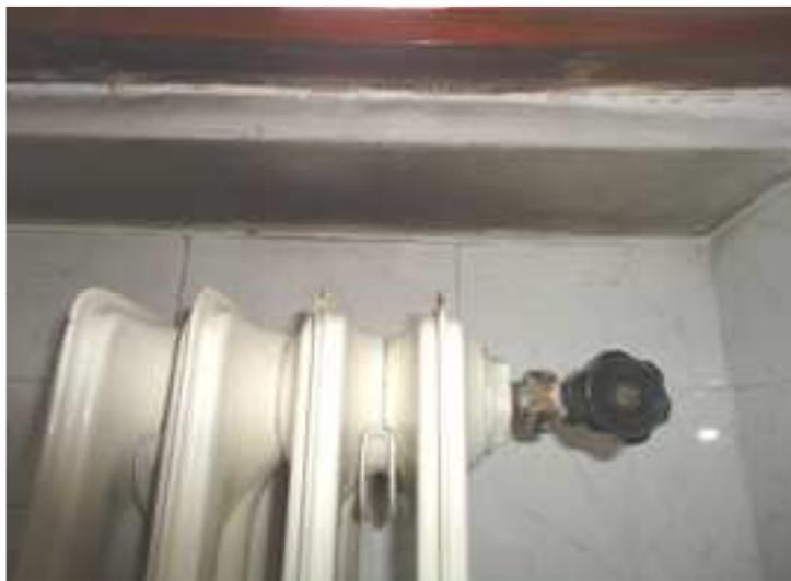
**Se sotto il marmo c'è un radiatore non si può tagliare per non indebolire eccessivamente la piastra. Conviene in questo caso isolare la parete ed il davanzale con l'applicazione di un pannello isolante**
